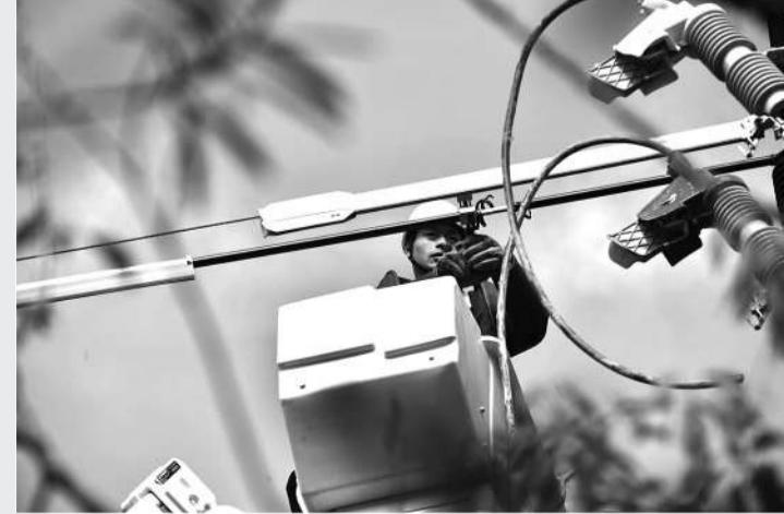
1月16日上午,桐乡市梧桐街道二环南路一块泥泞的田地里,一辆新式带电作业“神器”——履带式绝缘斗臂车正在开展带电作业。据悉,此次带电作业也是履带式绝缘斗臂车在浙北地区的首秀,仅用1.5小时就顺利完成文翔S795线45号杆,带电接跌落式熔断器上引线工作。
