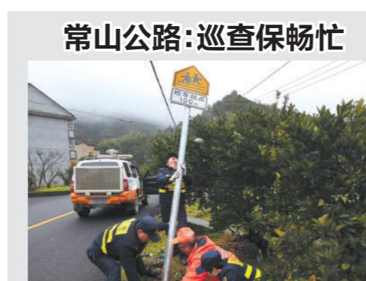
日前,常山县公路管理局芳村公路站的路政、养护人员巡查发现,有个校车接送点,指示牌被过往车辆撞倒在路上。他们赶紧下车带上工具,齐心协力把重400多斤底部连着水泥的指示牌一点一点移到原位扶正,消除安全隐患。
