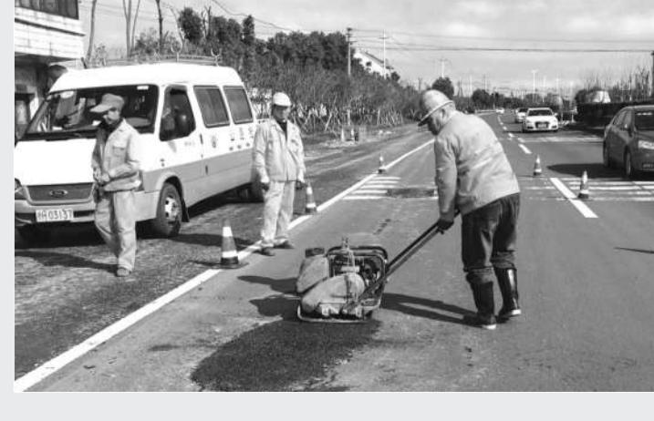
近日,柯城公路管理局趁着天气晴好,利用人工和专业机械将下沉、车辙等破损严重的沥青路面刨除、修复,消除安全隐患,确保道路平整、安全、畅通。
