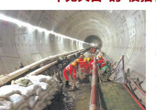
杭海城际铁路土建11标联络通道组主要负责盾构隧道内三个联络通道兼一座泵房的冷加固，以及区间长度约2220米的盾构左右两线之间搭设供风通风渠，由于工作环境艰苦，专业操作性强，资质要求高，联络通道组人员必须经常长时间待在隧道里作业，这让他们成为了“11标”不见天日的“夜猫子”。
