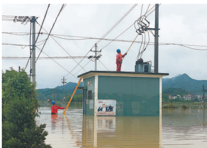
电力抢修人员正在抢修送电。
