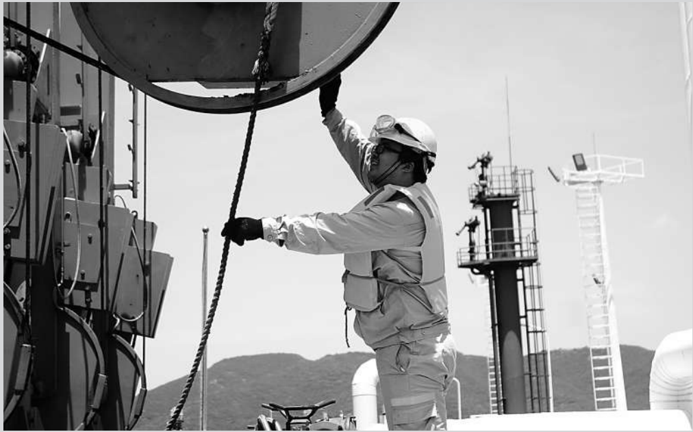
7月31日,针对连续高温天气,浙江舟山临港石化基地为了防止码头设备因憋压而出现“跑、冒、滴、漏”的安全隐患,及时对输油臂及管线等设备进行检查和保养,合理采取降温防憋压等安全防范措施,确保暑期作业的顺利进行。
