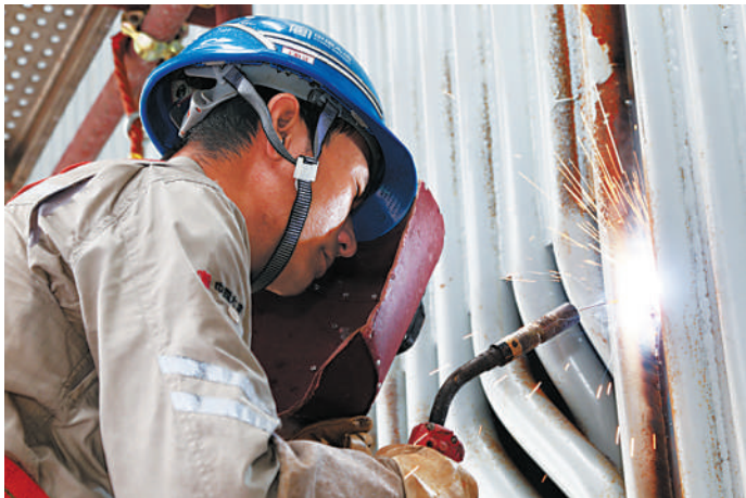
工人正在焊接启动锅炉管道。
