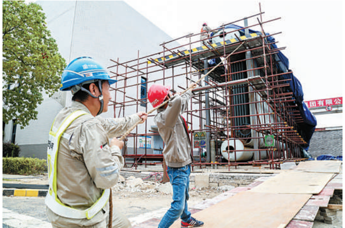
为防止设备在烈日下暴晒,工人给设备加盖遮阳布。
