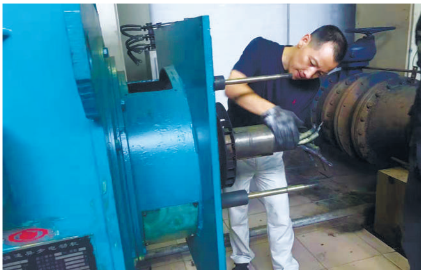
王永斌正在抢修供水电机集电环。
