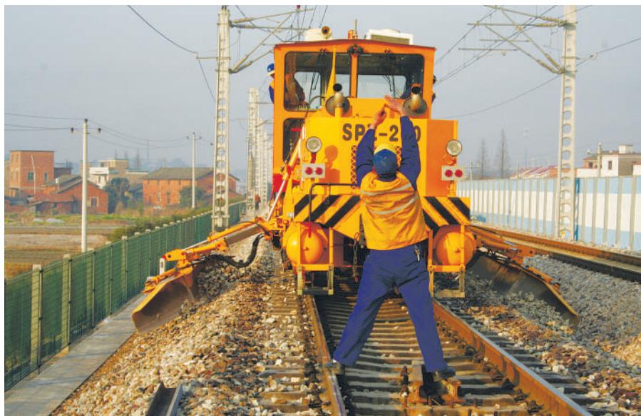
养路工指挥大型捣固车在沪昆线浙赣线作业。
