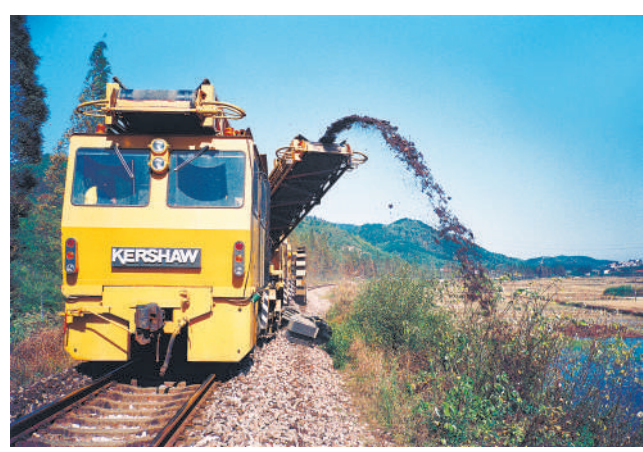
现代大型道砟清筛车在宣杭线作业,彻底解放了劳动力。
