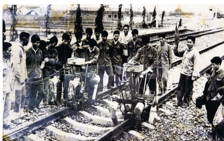
第一代电动捣固机试验现场。
