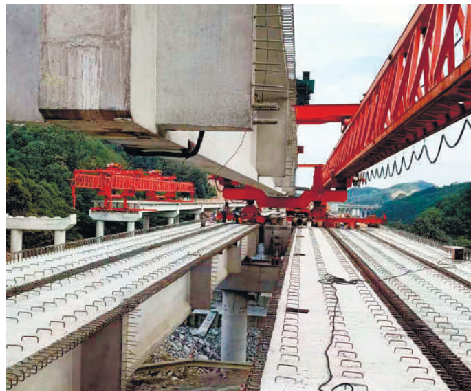
建金高速五标秦盘岭大桥正在架设梁板。
