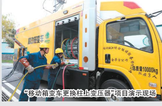
“移动箱变车可以临时代替柱上变压器，将10千伏转换为0.4千伏，直接将电送到周边居民或农村用户家中，实现变压器检修不停电。”11月22日，在国网金华供电公司配网实训基地，一场配网不停电作业技术观摩展示会正在进行。
