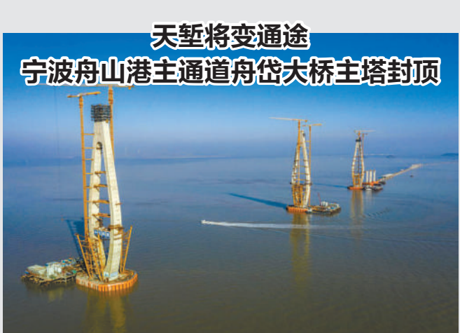
天堑将变通途 宁波舟山港主通道舟岱大桥主塔封顶 近日，浙江交通集团宁波舟山港主通道舟岱大桥，主通航孔桥ZT3#主塔最后一个节点浇筑完成，顺利实现封顶，标志着国内最大跨径三塔跨海斜拉桥主塔施工全部完成。 舟岱大桥主通航孔桥共3个主塔，采用钻石型塔身，主塔高度均为180米。主通航孔桥作为舟岱大桥关键控制性工程，索塔封顶这一重要节点的提前完成，确保了总体建设进度如期实现。 宁波舟山港主通道项目由甬甬门大桥、舟岱大桥和鱼山大桥三部分组成。全长36.777公里，批复总投资163.24亿元。目前鱼山大桥、甬甬门大桥已建成通车，舟岱大桥建设进度过半，计划于2021年底全线建成。大桥与甬舟高速连接，连岛工程跨越8个岛屿，总里程达到86.68km，将成为世界上最长的连岛高速公路和世界上规模最大的跨海桥梁群。 姚弘 曹家华 文/摄
