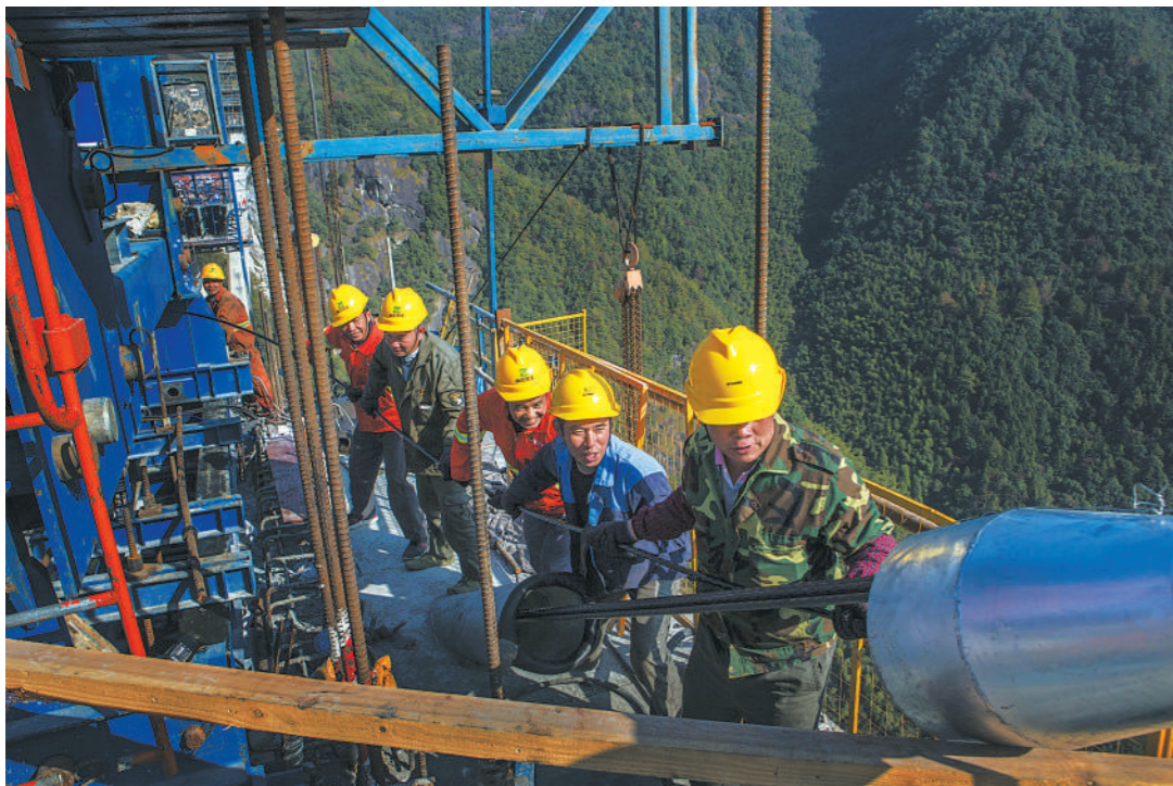
文泰高速项目洪溪特大桥建设者正在只争朝夕施工。
