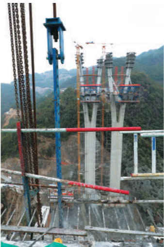
在距谷底260米的施工桥面上观望远方高达177米的高塔(桥墩)。 记者羊荣江 摄
