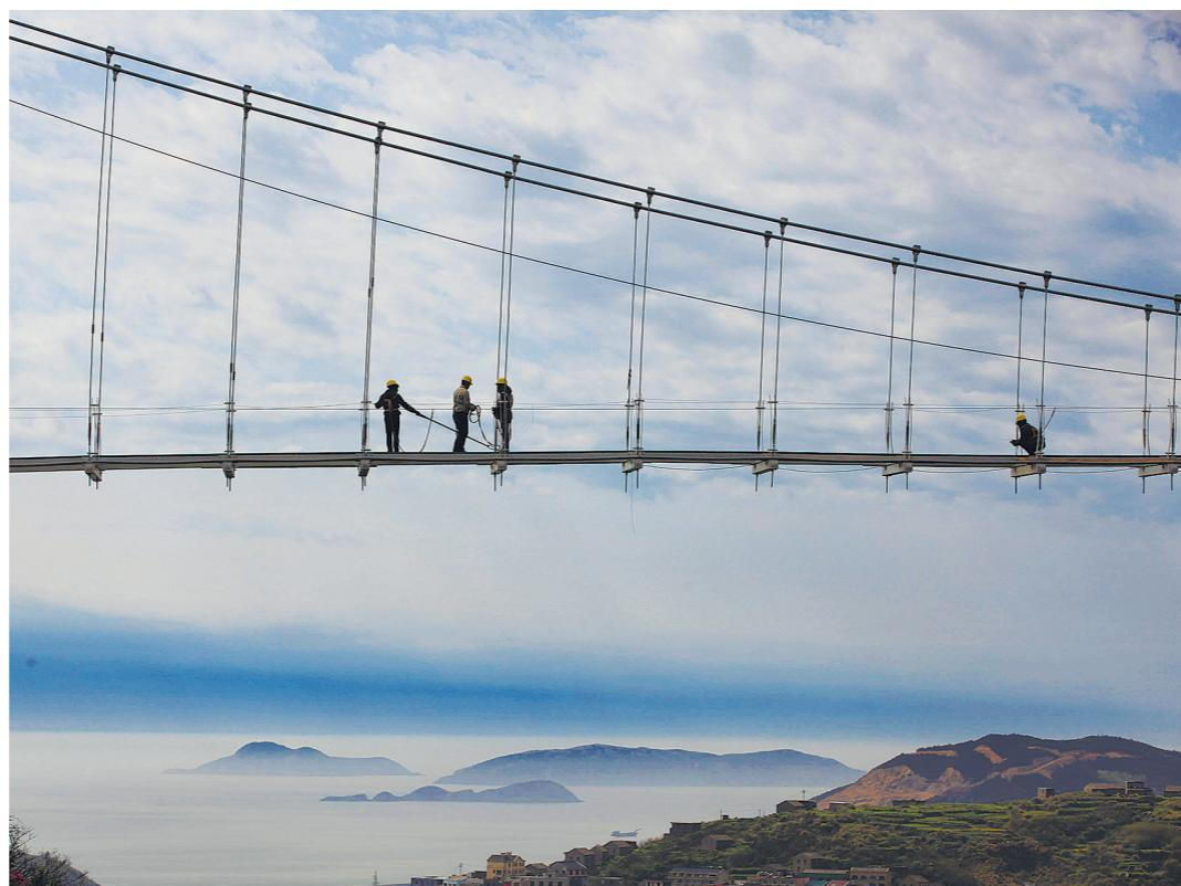
3月22日,在温岭市松门镇大坑沙旅游休闲项目建设工地上,建筑工人正在安装悬空玻璃索桥防护绳。
