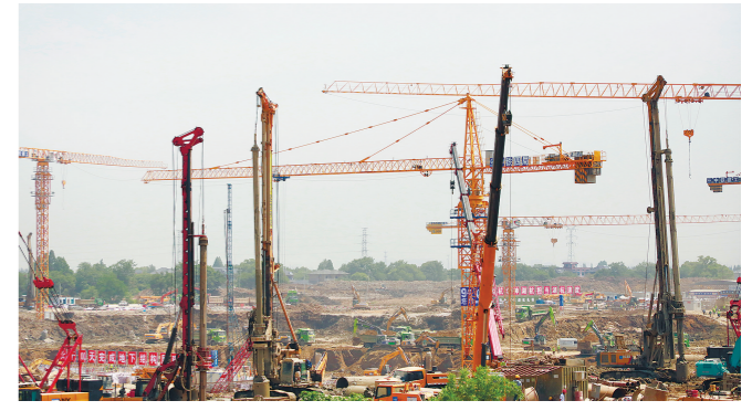
湖(州)杭(州)铁路是服务保障2022杭州亚运会的重要交通配套工程。自今年3月湖杭铁路项目全线开展“奋战四个月、打赢攻坚战”活动以来,截至5月22日,湖杭铁路项目当年完成投资21.9691亿元,占年度目标(80亿元)的27.46%;累计完成投资67.473亿元,占总投资概算(370.2703亿元)的18.19%。 记者羊荣江 摄
