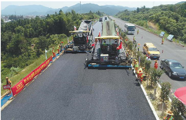
建金高速公路项目沥青铺路工人在160℃路面上施工。
