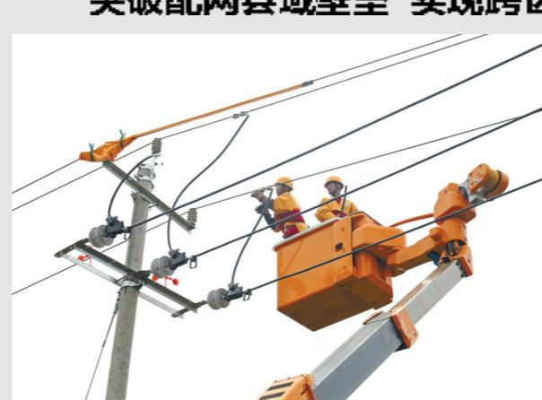
稳定。长兴10千伏659线与安吉913线的正式联通，打破配网在管理和技术上的壁垒，进一步提升供电可靠性。
