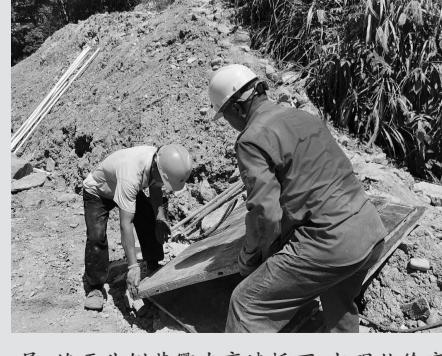
近日,在开化县徐齐线改造工程禾丰村段,工人们正冒高温、顶酷暑,忙着开挖路基、浇筑挡墙。
