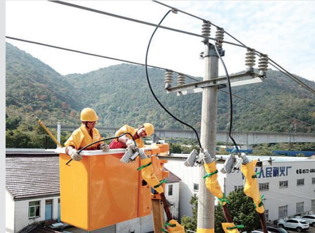
“10千伏弁山554线换线工作已全部结束，人员已撤离，申请恢复重合闸！”近日，国网长兴县供电公司带电作业项目部完成了湖州地区首次主干线路旁路作业，实现第四类带电作业新突破。
