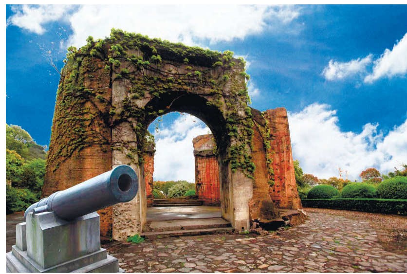
安远炮台,东南沿海保存最完整炮台之一,建于1885年中法战争期间。因用黄沙、黏土、石灰、砂砾拌以糯米饭汁混合捣砌而成,当地人称它为“糯米饭炮台”。
