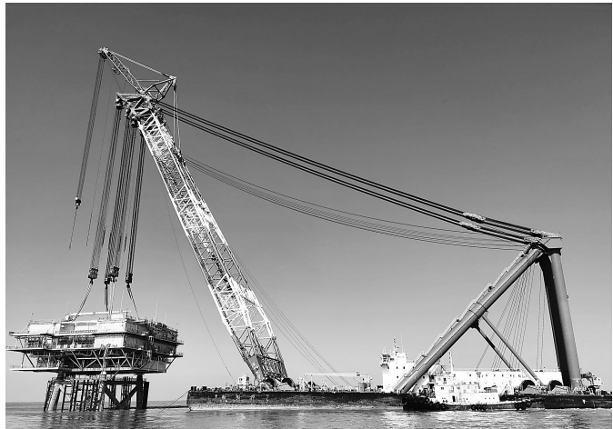
嵊泗2号400兆瓦海上风电项目海上升压站完成吊装。
