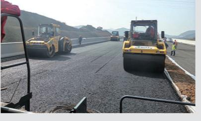
近日，舟山天气转晴，施工条件尚可，浙江交通集团宁波舟山港主通道项目舟岱大桥恢复路面作业。项目部抢抓时机，加快工程进度，计划于5月底完成大桥陆域段所有沥青面层施工，10月下旬完成舟岱大桥全桥路面沥青施工，确保年底实现通车目标。图为路面沥青施工现场。
