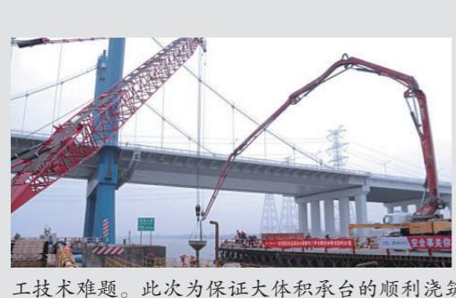
日前,随着最后一方混凝土灌于水底,浙江交通集团杭绍甬高速杭绍段四分部曹娥江特大桥首个主墩承台封底完成,大桥正式进入承台施工阶段。
