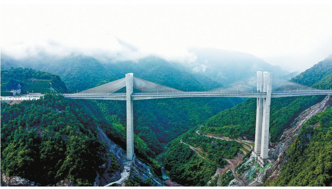
图为亚洲双塔双索面最大跨径的矮塔斜拉桥——洪溪特大桥。张锦国 摄
