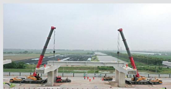
9月1日8时32分，伴随着两台300T汽车吊的轰鸣声，长达30米、重约77吨的预制T梁缓缓降落在杭绍甬高速杭绍段项目萧山三号桥47+48号右幅盖梁上。这是杭州侧安装的首片梁板，标志着杭绍甬高速杭绍段项目建设接下了快进键。
