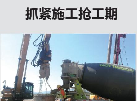
浙西窗口“南北通道”工程位于杭金衢高速常山服务区,项目全长915米,预计2022年9月完工。“十一”假期,负责该项目的常山县交通工程组的工人坚守岗位,节后又抢抓工期,紧张有序开展跨高速公路桥的桩基施工。
