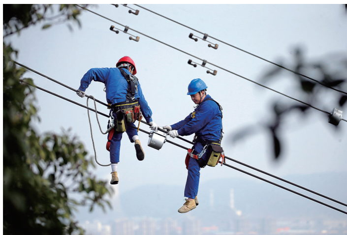
输电人员正在安装线路在线监测装置。
