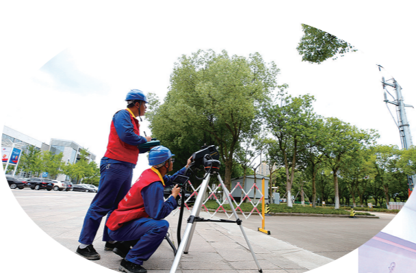
输电运检人员利用激光炮消除线路隐患。
