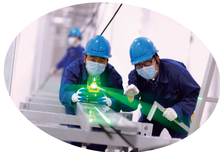
送变电人员正在利用智能定位仪校正设备位置。
