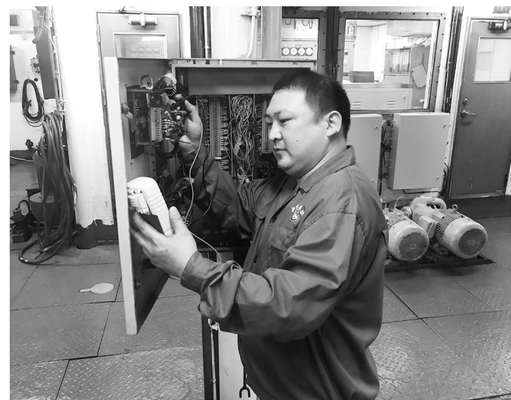
方威力正在检修电气控制箱。
