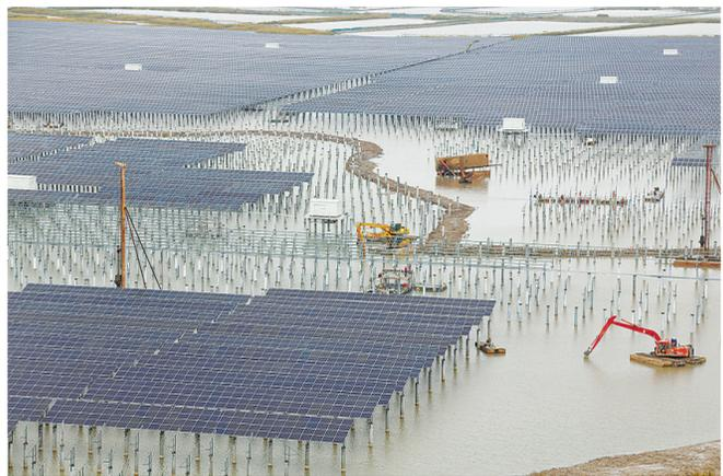
昨日,玉环市清港镇苔山塘海涂上,工人们正忙碌着架设光伏架、安装光伏板,赶工期早日建成省重点建设项目——华能玉环清港1800亩滩涂渔光互补光伏电站。 通讯员詹智 摄
