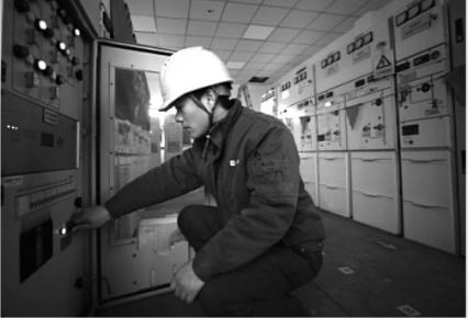
目前，萧山区钱江世纪城20千伏美丽开，浙江中新电力建设有限公司工作人员开展了环境系统升级工作，全新优化升级的配电自动化辅助监测装置安装调试后，收集的环境信息精准反馈到后台，不仅为开闭所内设备稳定运行打下坚实基础，还提升了周边居民、企业的用电可靠性。
