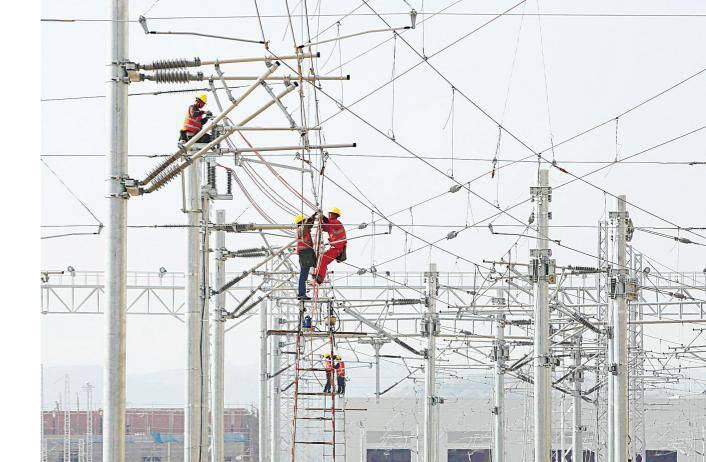
昨日,台州市域铁路S1线温岭市城南路段,建设者在安装铁路接触网开关引线。
