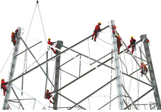
4月17日，位于玉环市丁岙自然村前的220千伏线路工程施工现场，20多名施工人员正在组装、架搭50米高的猫头形铁塔。
