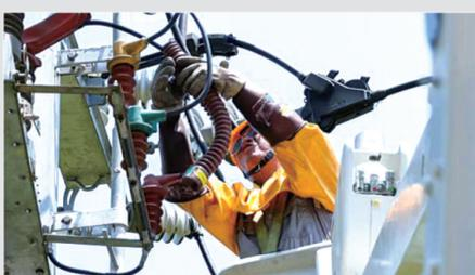
瑞安供电带电作业中心工作人员在烈日下,身穿两层棉手套加绝缘手套开展作业,以进一步提升瑞安电网的智能化水平。
