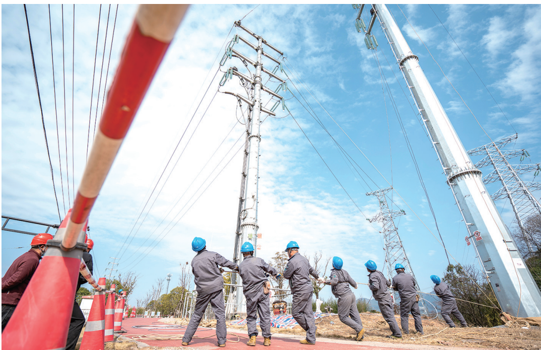
1月27日，在东方日升（义乌）新能源有限公司110千伏专线提升工程现场，国网义乌市供电公司员工正在有序施工，确保该项目顺利投产，保障企业节后复工复产“电力十足”。（陈姣姣 陈紫涵 摄）
