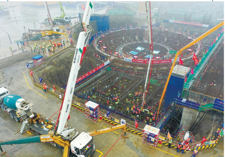
近日,中核集团旗下中国核电投资控股的三门核电有限公司4号机组浇筑核岛第一罐混凝土(FCD),这标志着三门核电二期工程建设序幕全面拉开。
