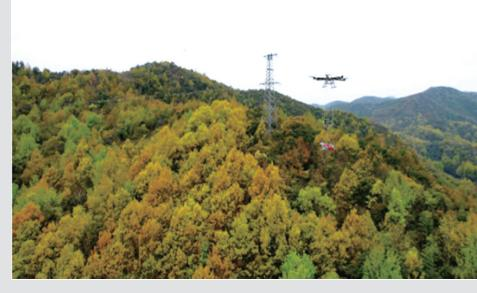
日前,在象山涂茨道人山,随着国网象山县供电公司工作人员的操作,一架无人机跨越河道,穿山越岭,将吊装着近百斤重的塔材运送到百米之高的新建铁塔基础作业点,这也是全省首次在配网工程中运用多旋翼重载运输无人机吊装电力施工材料。
