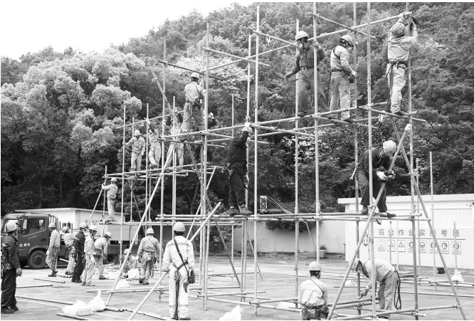
图为学员分组进行钢管架搭设实操考试。
