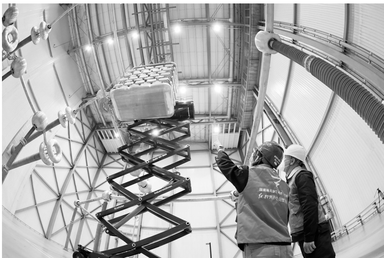
运检人员在检查直流滤波器等设备运行情况。通讯员刘海山 摄
