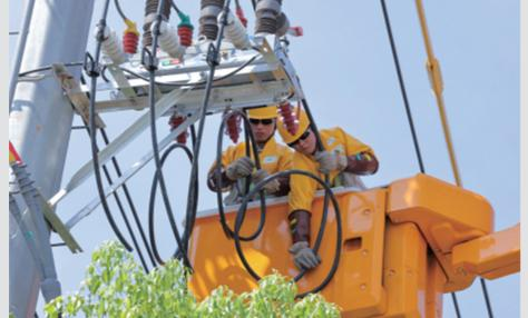
近日,国网瑞安市供电公司带电作业分中心员工头顶烈日,在云周街道10千伏新丰M271线6#杆开展带电搭接量子开关引流线作业,为黄垟
