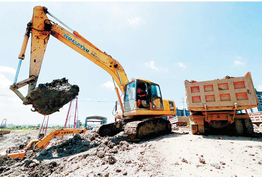
现场多台挖机正在开挖土方。
