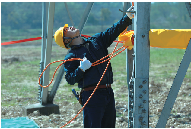
2023年3月,国网金华供电公司“蒋卫东带电作业特战队”正在500千伏双兰线开展带电更换复合绝缘子作业,蒋卫东在塔下协助工作。(摄影 张守成)
