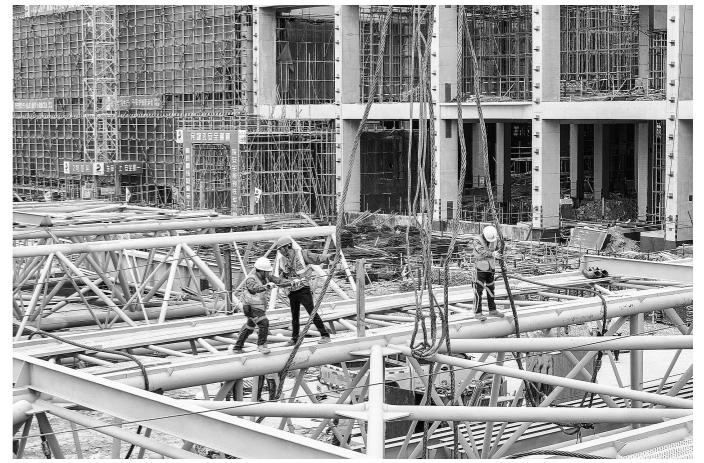
本报记者 姜文韬报道 日前,浙能六横电厂二期项目百万千瓦3号机组第一榀钢屋架梁成功吊装,标志着项目自主厂房建设由土建转入设备安装阶段。浙江二建建设者奋力攻坚,比计划提前一个多月实现该节点,助推项目早日建成投产。
