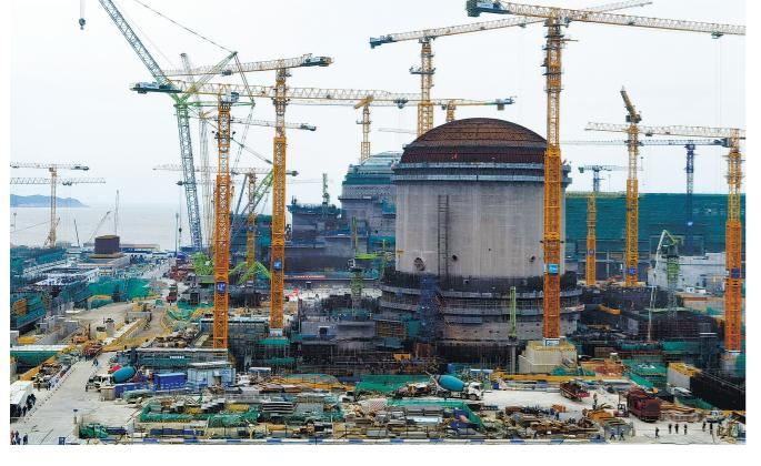
近日,位于苍南的中广核浙江三澳核电项目2号机组顺利完成穹顶吊装,从土建施工阶段全面转入设备安装阶段。目前,该项目1号机组反应堆压力容器、蒸汽发生器等主设备已就位,正在推进主管道焊接。
