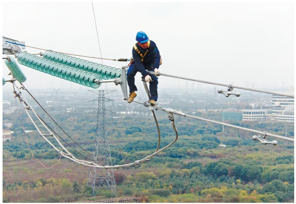
近日,国网嘉兴供电公司高空验收组人员爬上了高度为50多米的铁塔上,对220千伏由青4R23线、由石4R24线开展投产前竣工验收工作。
