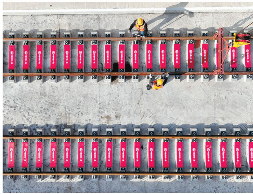
11月28日,位于德清县康乾街道的杭德市域铁路轨道工程施工现场,随着全线第一节轨排稳稳落下,杭德市域铁路开始进入铺轨阶段。作为浙江省重点
