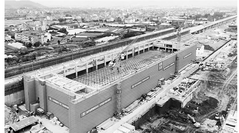
本报讯 记者羊荣江报道 近日,在浙江交通集团杭温铁路二期浦江站施工现场,12台液压顶升机将重达360吨的巨型钢铁“帽子”缓缓顶起,标志着高铁浦江站屋面钢结构网架顶升到位,为接下来的装饰装修工程施工奠定了坚实基础。
