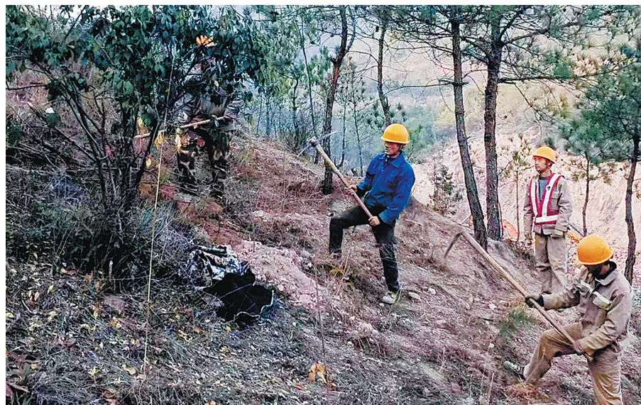
施工人员正在开挖铁塔接地沟。
