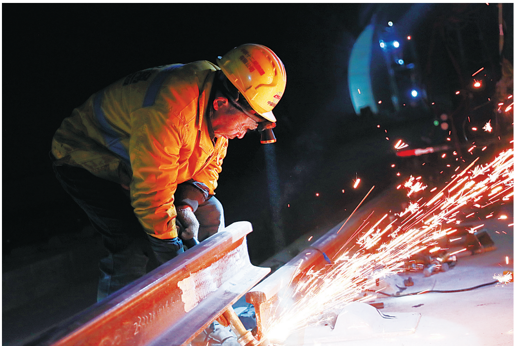
金台尖隧道内轨道连接点,建设者对钢轨接头进行抛光。
