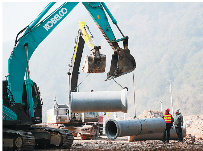
桐庐小溪溪大桥桥底的土建施工,建设者正在吊装排水管网。
