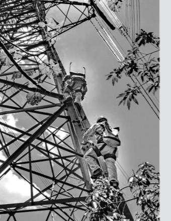
7月4日,国网金华供电公司“蒋卫东带电作业特战班”在永康市前仓镇,对500千伏金康线引线发热隐患开展带电消缺。
