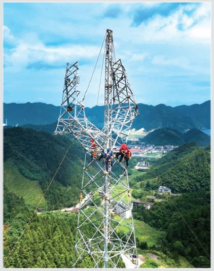
7月11日,开化县华埠镇崇山峻岭间,一队电力工人正顶着烈日架设电力铁塔。他们身穿厚重的工作服,头戴安全帽,手戴防护手套,用滑轮将钢构件吊升至铁塔顶端,固定在塔身上。泛着银光的电力铁塔,不断向高空延伸……
